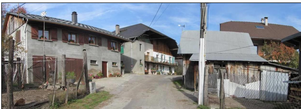
Photo 29 : Alignement du bâti au Villard
