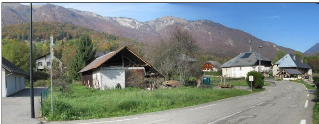
Photo 22 : Espace peu entretenu au nord de la salle des fêtes, avec un bâtiment non terminé
