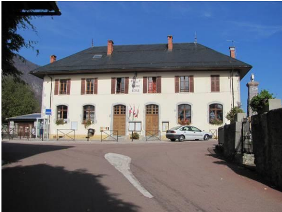
Photo 19 : Place de la Mairie
