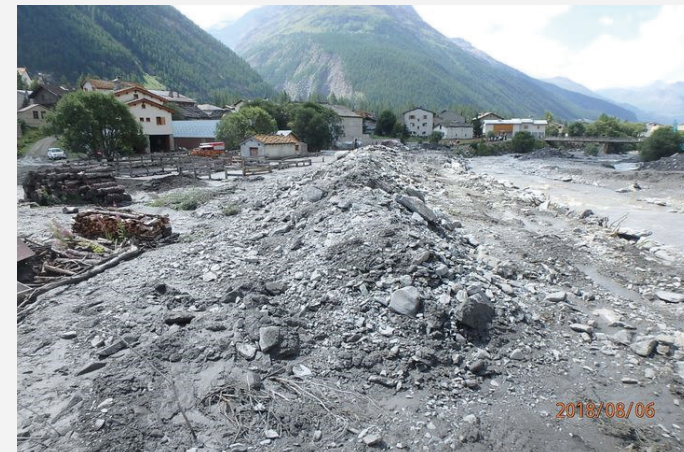
> Lave torrentielle dans le torrent du Claret à Bessans le 06/08/2018 - photo : ONF/RTM
