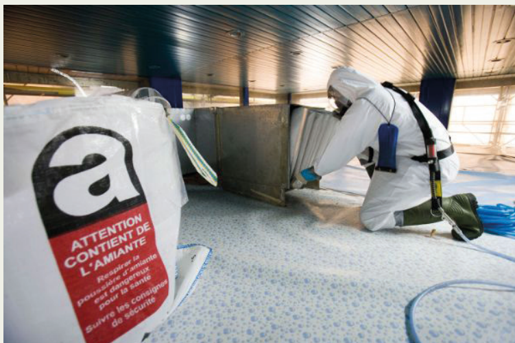
> Chantier de désamiantage - photo : INRS
