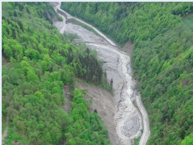
> Crue de l'Arly le 01/05/2015, emportant la RD1212 - photo : ETRM
