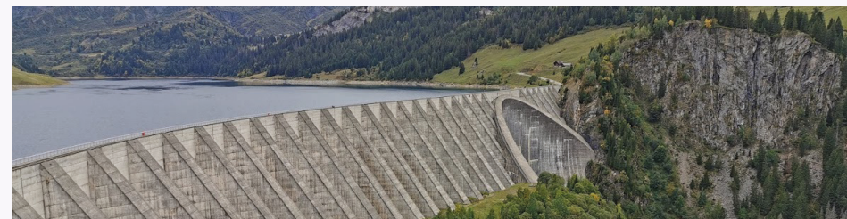
> Barrage de Roselend - photo : Préfecture de la Savoie
