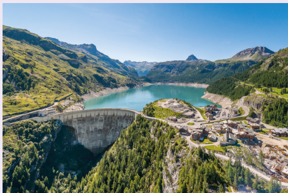
> Le barrage de Tignes - photo : Préfecture de la Savoie
